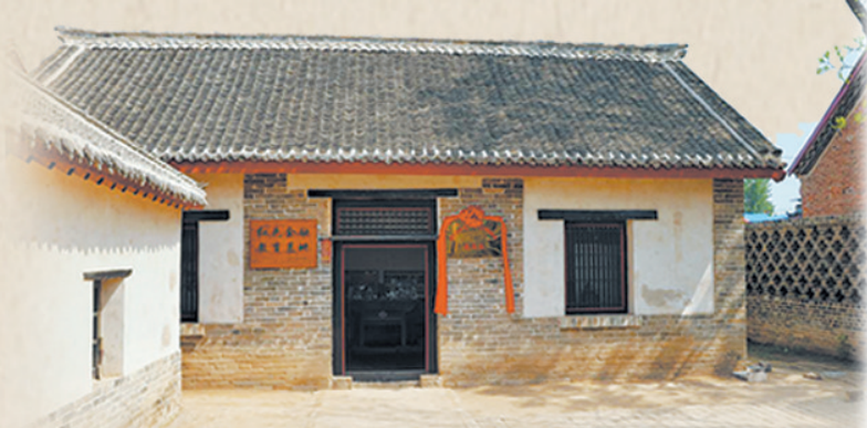
修缮后的鲁西银行印刷所旧址
